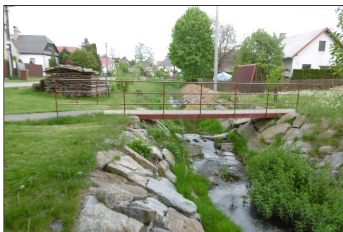
Lávka 10d-L1 - staničení 0,026 - pohled zleva
