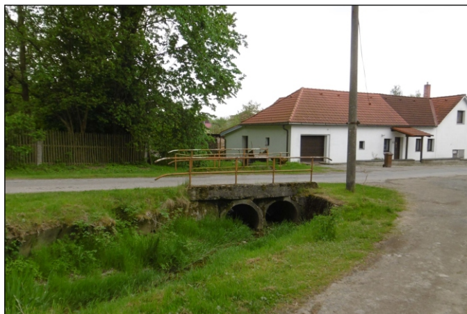
Propustek 26c - staničení 0,459 - pohled zleva
