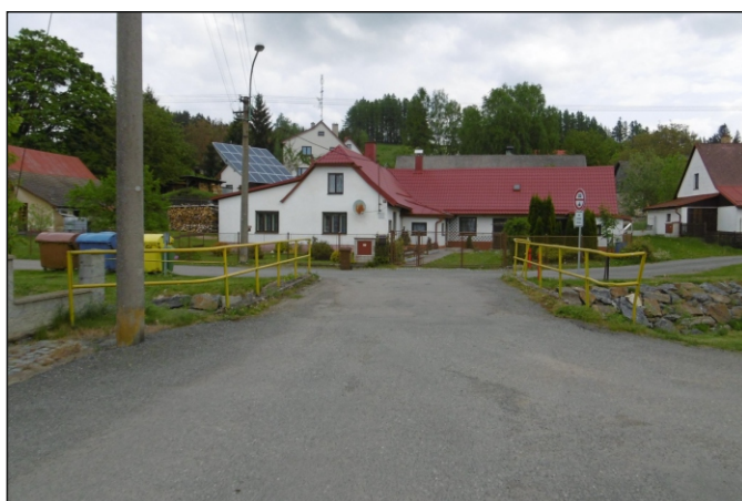
Most 9c-M1 - staničení 0,130 - celkový pohled
