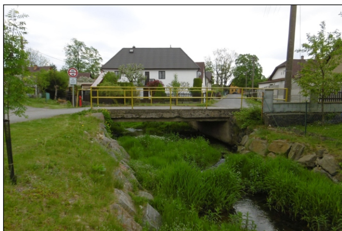
Most 9c-M1 - staničení 0,130 - pohled zleva
