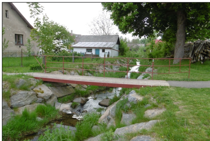
Lávka 10d-L1 - staničení 0,026 - pohled zprava
