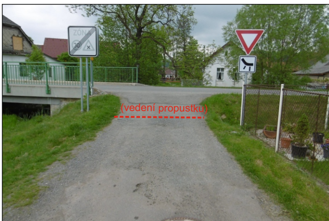
Propustek 26c - staničení 0,003 - celkový pohled
