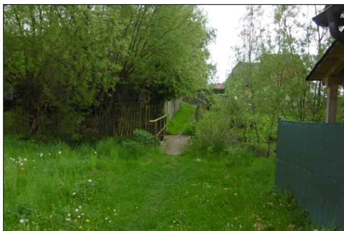
Lávka 12d-L1 - staničení 0,001 - celkový pohled
