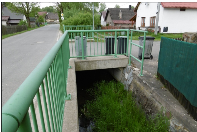
Propustek 17c - staničení 0,001 - pohled zprava
