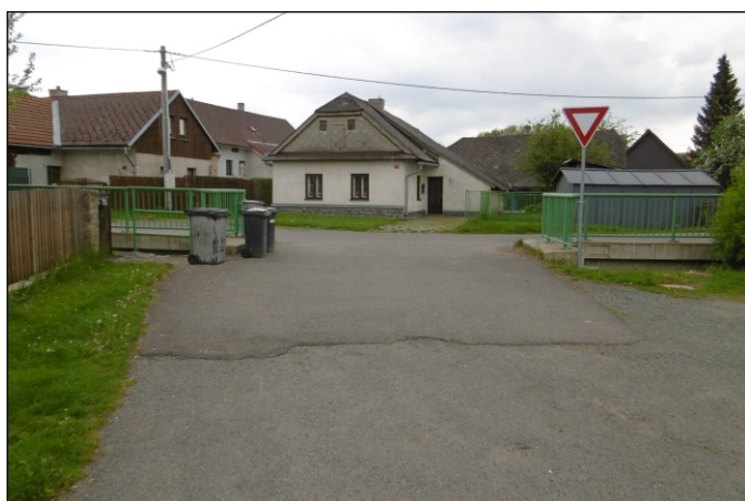
Most 17c-M1 - staničení 0,001 - celkový pohled
