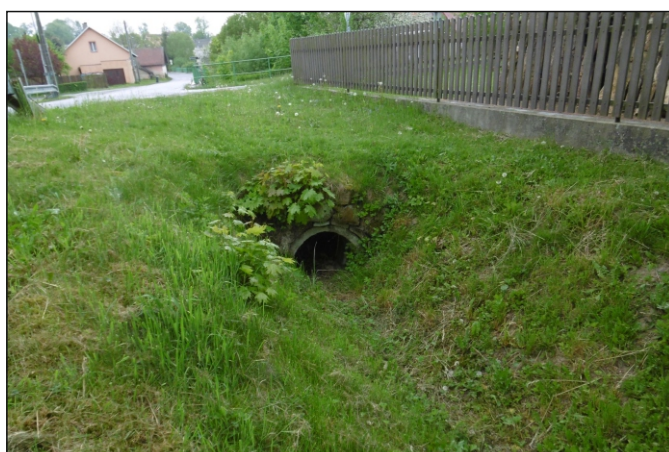
Propustek 14c - staničení 0,001 - pohled zprava
