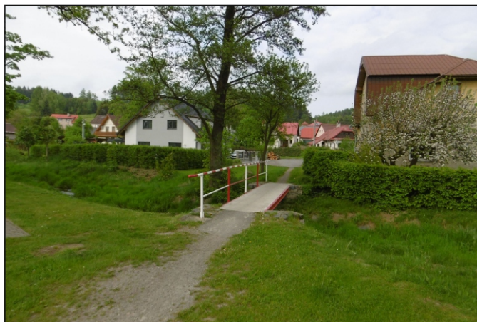
Lávka 11d-L1 - staničení 0,005 - celkový pohled
