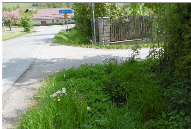
Propustek 1c - staničení 0,209 - pohled zleva
