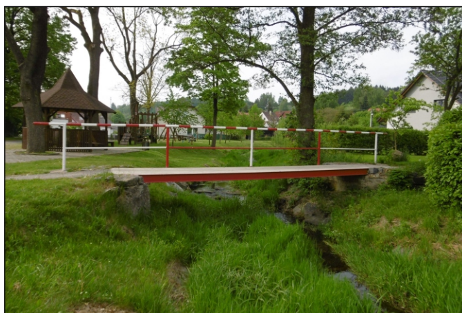
Lávka 11d-L1 - staničení 0,002 - pohled zprava
