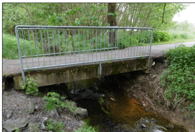
Lávka 9d-L1 - staničení 0,065 - pohled zleva
