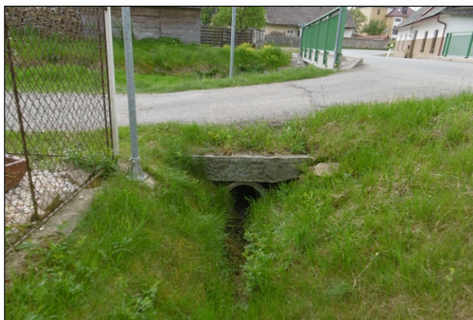
Propustek 26c - staničení 0,003 - pohled zleva
