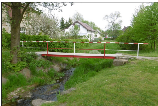
Lávka 11d-L1 - staničení 0,002 - pohled zleva
