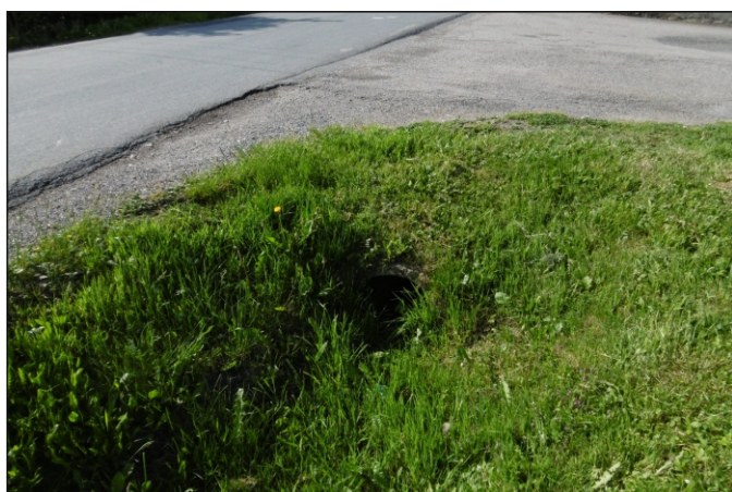
Propustek 4c - staničení 0,001 - pohled zprava
