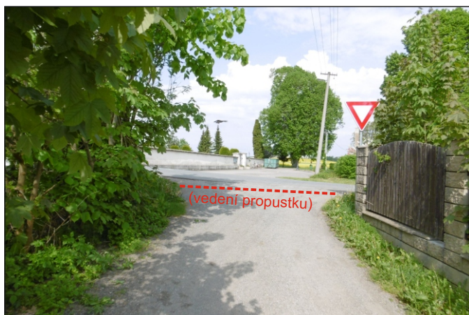
Propustek 1c - staničení 0,209 - celkový pohled
