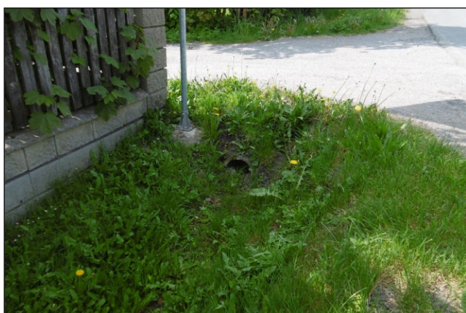
Propustek 1c - staničení 0,209 - pohled zprava
