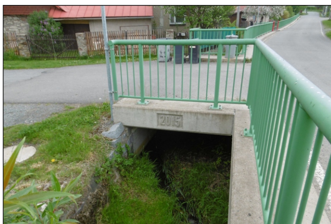
Most 17c-M1 - staničení 0,001 - pohled zleva
