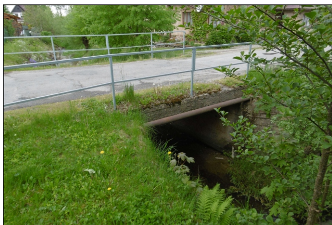
Most 25c-M1 - staničení 0,154 - pohled zprava
