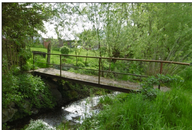
Lávka 12d-L1 - staničení 0,001 - pohled zleva
