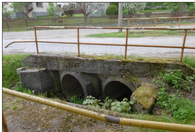
Propustek 26c - staničení 0,459 - pohled zprava
