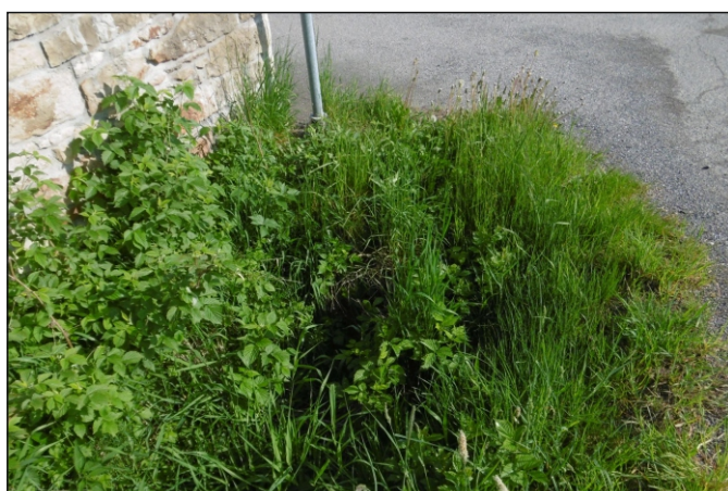
Propustek 4c - staničení 0,001 - pohled zleva
