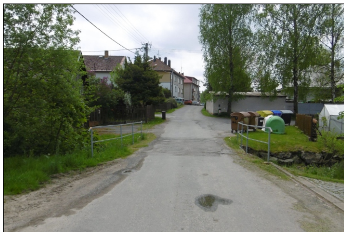
Most 25c-M1 - staničení 0,154 - celkový pohled
