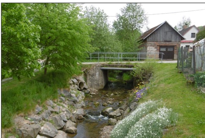
Most 25c-M1 - staničení 0,154 - pohled zleva
