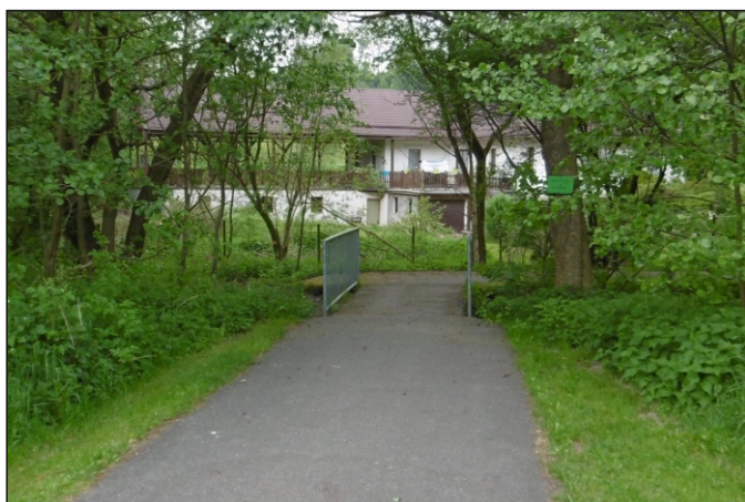
Lávka 9d-L1 - staničení 0,065 - celkový pohled
