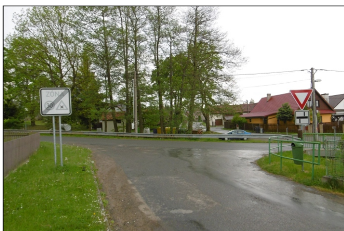
Propustek 14c - staničení 0,001 - celkový pohled
