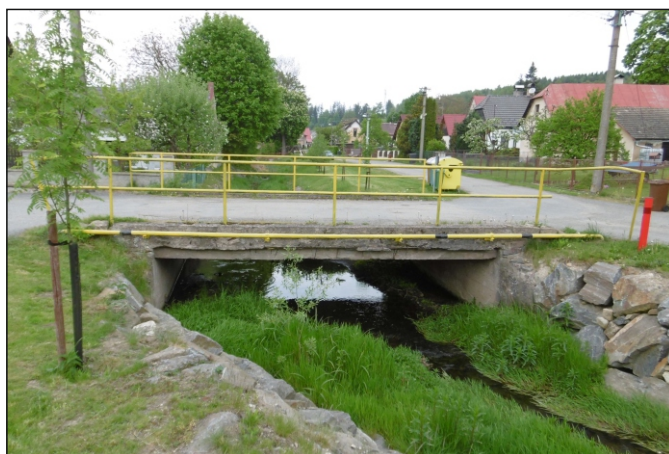
Most 9c-M1 - staničení 0,130 - pohled zprava
